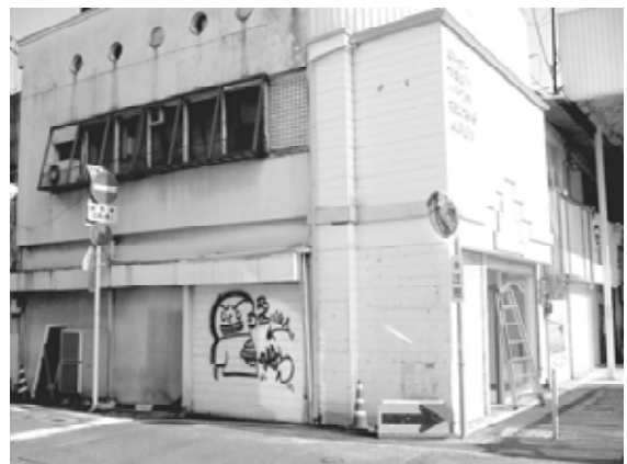
商店街の入口にある店舗の修理前
