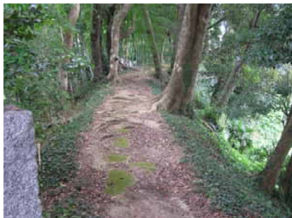
怡土城の土塁の最上部
