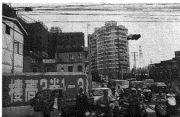
新竹科学工業園区の最後の工区のあたりは大車輪の工事中であった
