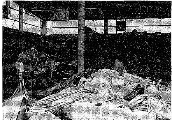
大規模なストックヤードを持つ水俣市清掃センター
