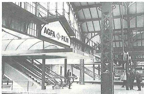
写真3 プラットホームのエスカレーター
