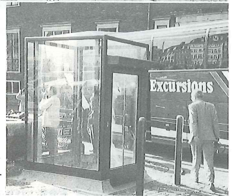
写真2 地下公衆トイレのエレベーター
