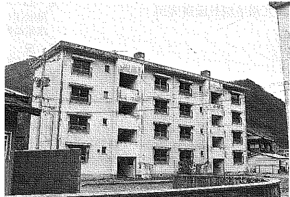
空き家になっている公営住宅
