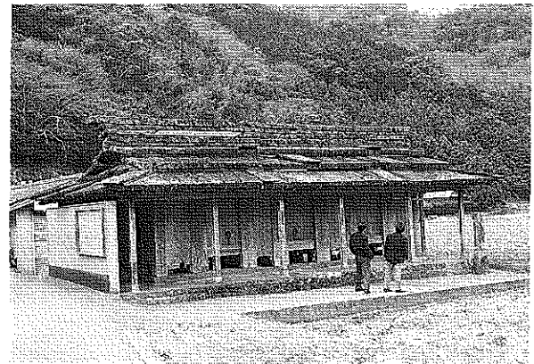
対馬・厳原町椎根の石屋根 穀物を貯蔵した倉庫、床下を風が通りぬけるようになっている
