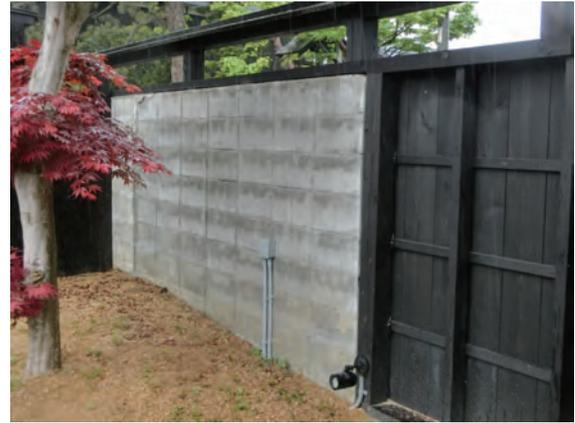
経費節減と工法を簡単にするため、ブロック塀に直接貼り付けている
