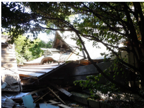
全壊状態の木山神社。地域のシンボルとなっていた神社。拝殿はいち早く解体していた
