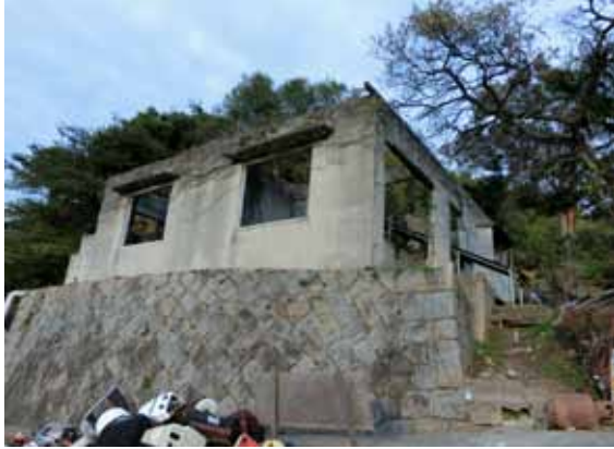
ダンサーのアイデアで、窓にステージを作ってダンスパフォーマンスをしたブロック造の廃屋
