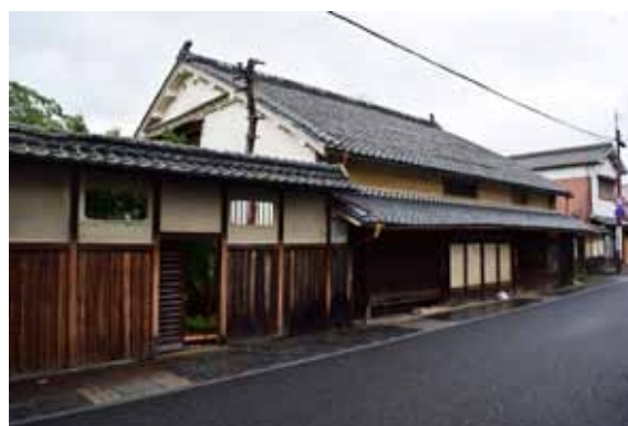
改修中だった篠山城下町ホテルの一棟
