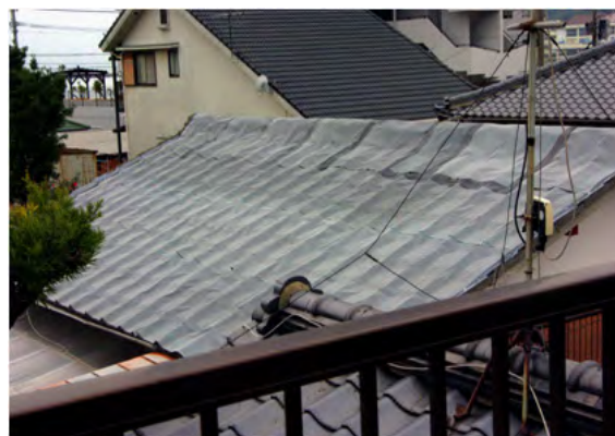
雨漏りの防水状況
