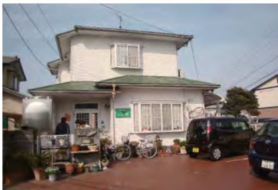
看板がなければ通り過ぎてしまいそうな小規模多機能施設「なごみの家」
