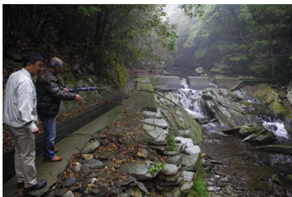
水路の入口。岩盤の上に堰がつくられている。
