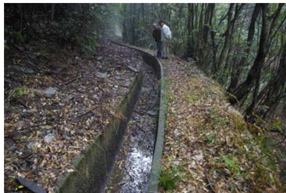
勾配に沿って蛇行する4.2kmの大井手水路。保全組合の帯山さんに案内していただいた。
