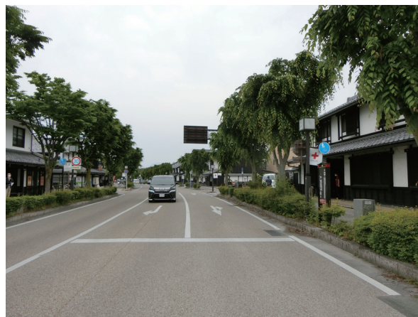
夢京橋キャッスルロードの町並み 木造 2 階建てとケヤキの街路樹の品格の漂う町並み景観
