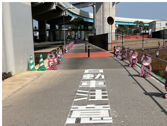
実現した MJR 駐車場進入口の安全対策（右側が MJR 側、左側が高速道路側、手前が歩道上の注意の標識、交差点部をカラー舗装化）
