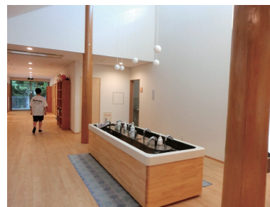
廊下手洗い：上部に高窓、廊下の突き当りに掃き出し窓を設けている
