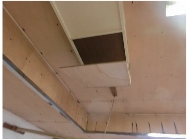
麹室～温度調整のための換気口
