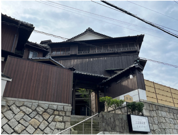
木造3階建ての三宜楼 1階を料亭として活用
