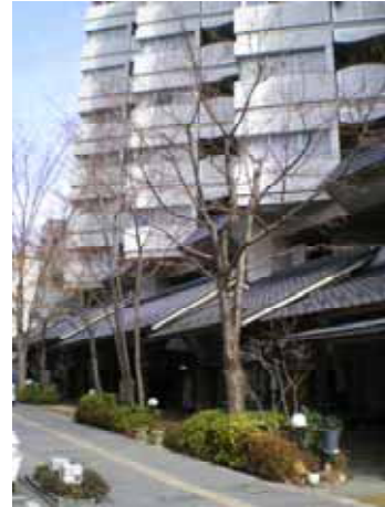
マンションの1階の瓦庇(長野)
