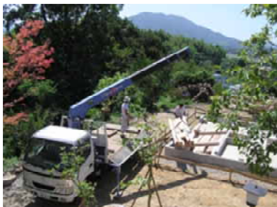
加工した材をウインチのついたトラックで運んできて、棟上げ
