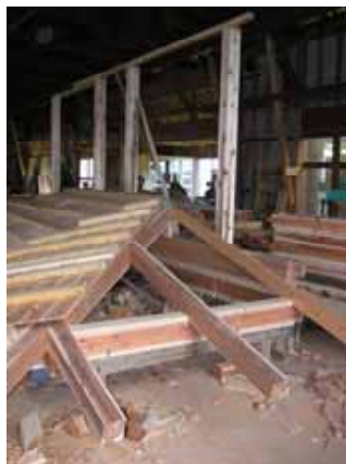
現代の大工小屋は常設で、いろいろな大工機具が揃っている。そこで一旦組み立ててみて解体して再度棟上げに
