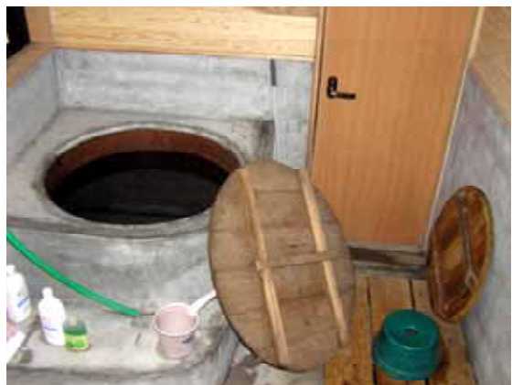
五右衛門風呂は底板(右の小さい丸板)が浮いてくる
