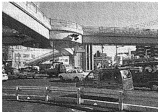
誕生したばかりの歩道橋
