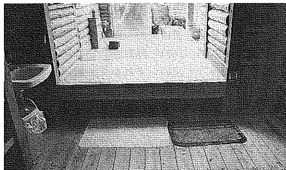
一段床面が車椅子分だけ高くなっている脱衣室
