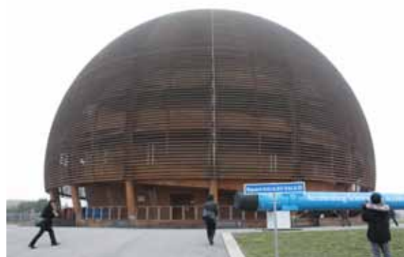
The Grove の外観。地球を思わせる球形で、環境に配慮した木製の建造物。
