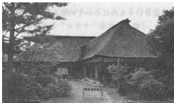
民宿「曲がり家」、手前の棟に泊めていただいた
