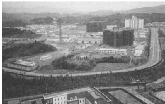
リゾートマンション建設中： 新聞には「進む社用リゾート化」と書かれている
